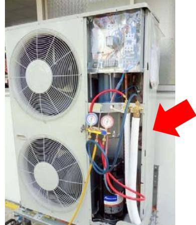
圖 6、冰水管路應妥善包裹適當材料之保溫棉以維持冷房效果
